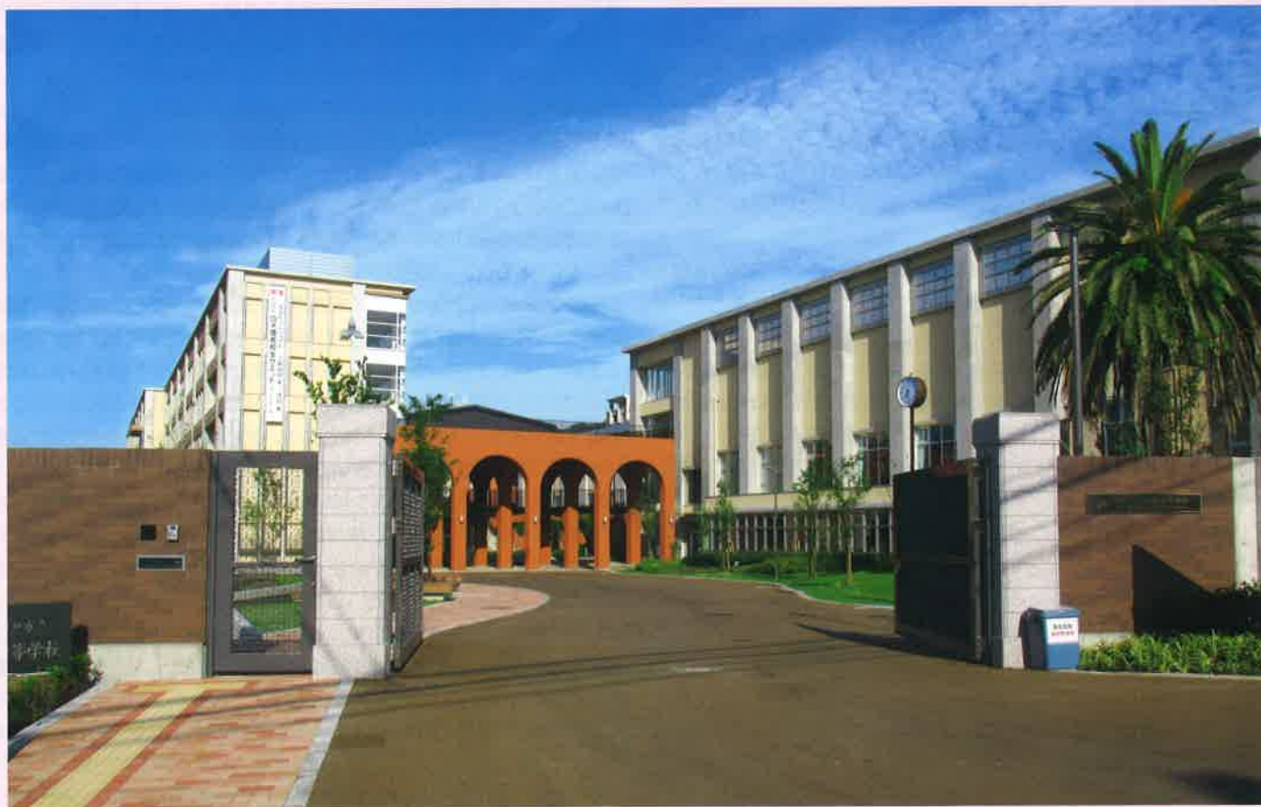
平成28年6月に完成した新校舎
