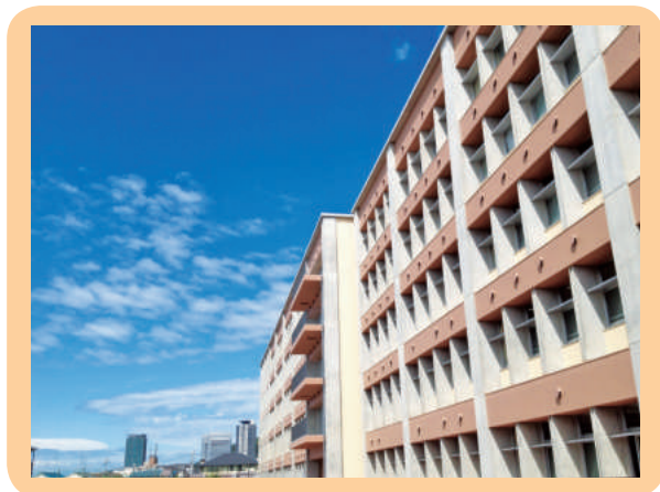
平成25年12月に完成した本館（校舎棟）
